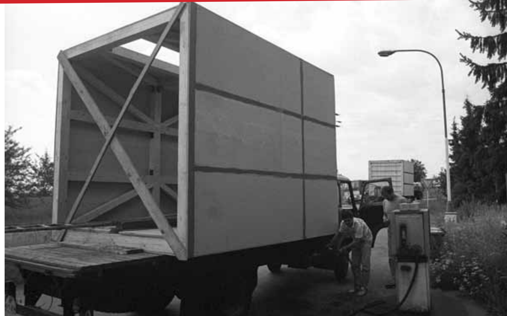
Obě konstrukce opláštěné dřevotřískovými deskami vezla nákladní auta z dílny ve Vítějevsí do Prahy vcelku. Koruna byla rozebrána na jednotlivé trny dopravované samostatně.
