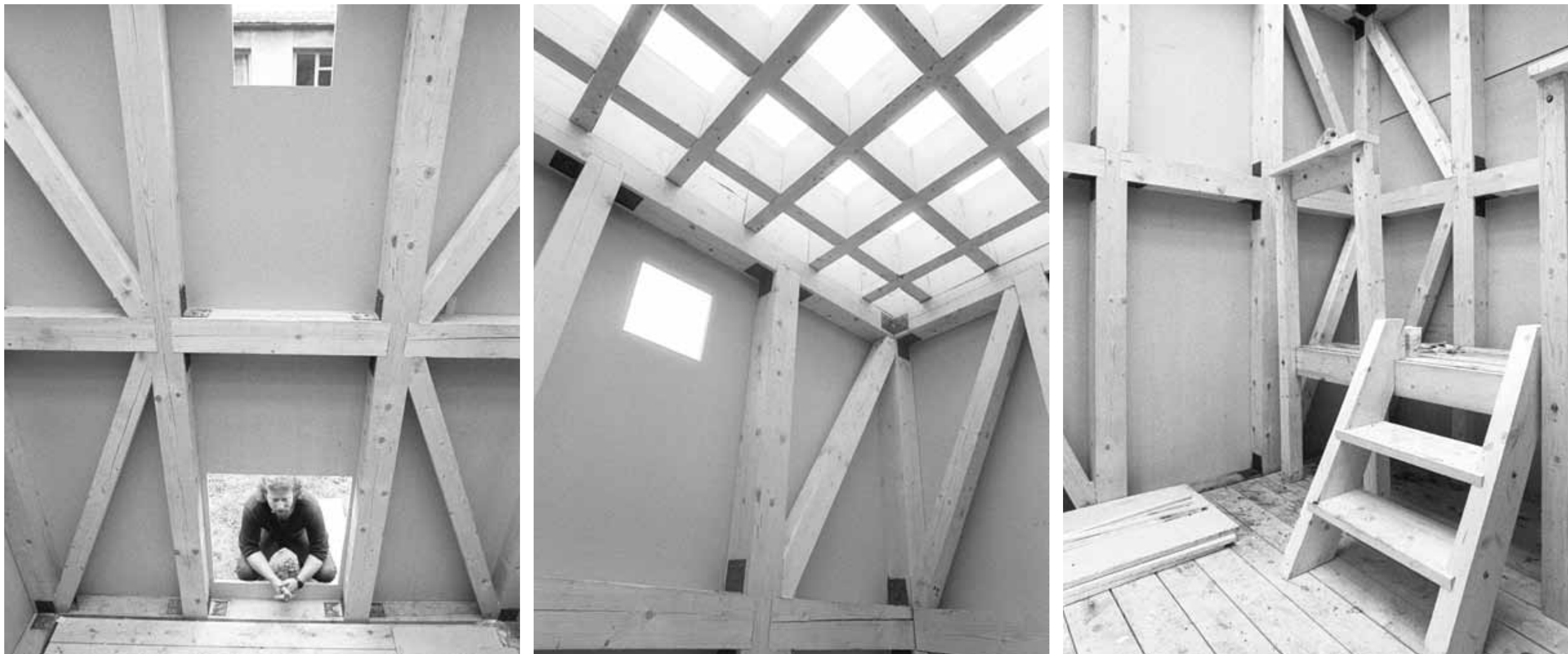
Pohled do interiéru Domu matky sebevraha na vnitřní konstrukci z opracovaných trámů. Stavba podesty a přístupových schůdků byla dokončena až na místě.
