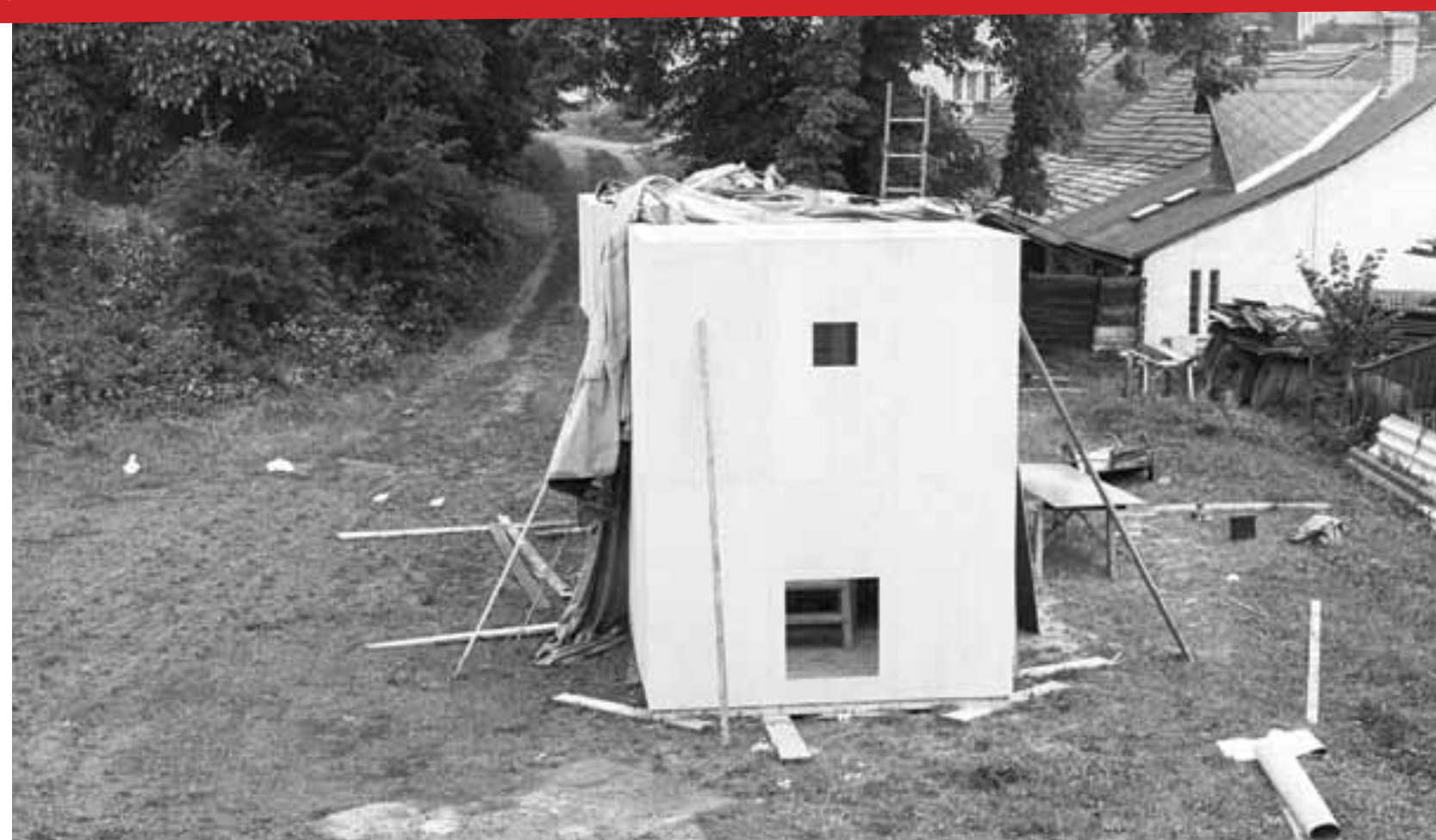
Obě konstrukce opláštěné dřevotřískovými deskami vezla nákladní auta z dílny ve Vítějevsí do Prahy vcelku. Koruna byla rozebrána na jednotlivé trny dopravované samostatně.
