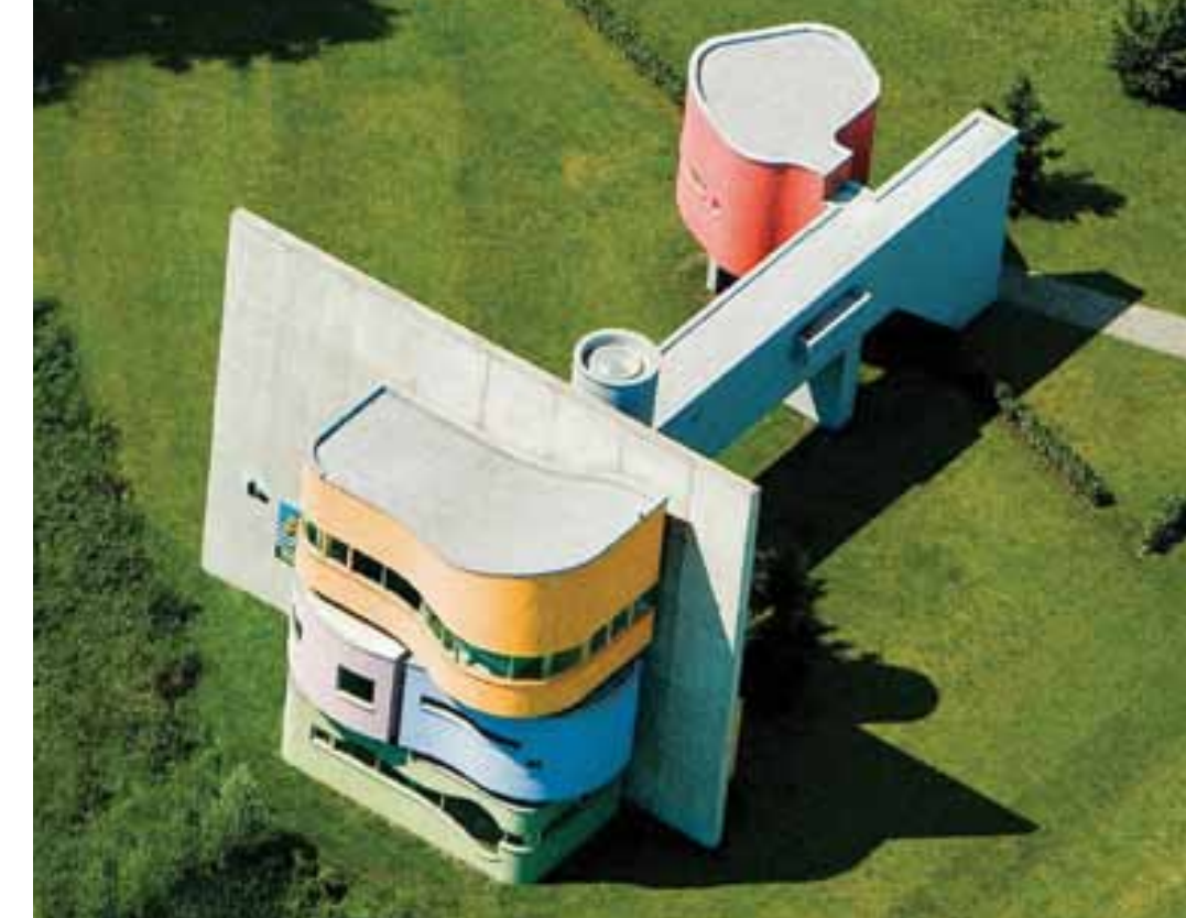
Wall House #2, Groningue Nizozemí, 2001
