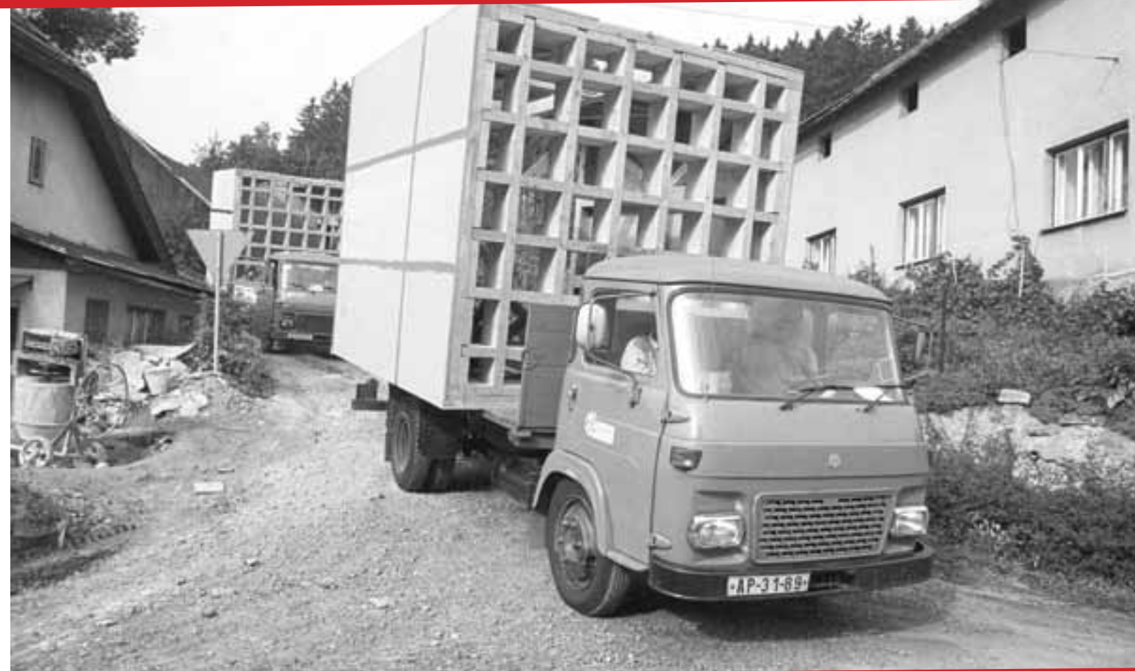
Obě konstrukce opláštěné dřevotřískovými deskami vezla nákladní auta z dílny ve Vítějevsí do Prahy vcelku. Koruna byla rozebrána na jednotlivé trny dopravované samostatně.
