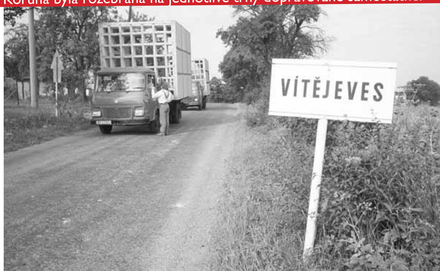
Obě konstrukce opláštěné dřevotřískovými deskami vezla nákladní auta z dílny ve Vítějevsí do Prahy vcelku. Koruna byla rozebrána na jednotlivé trny dopravované samostatně.
