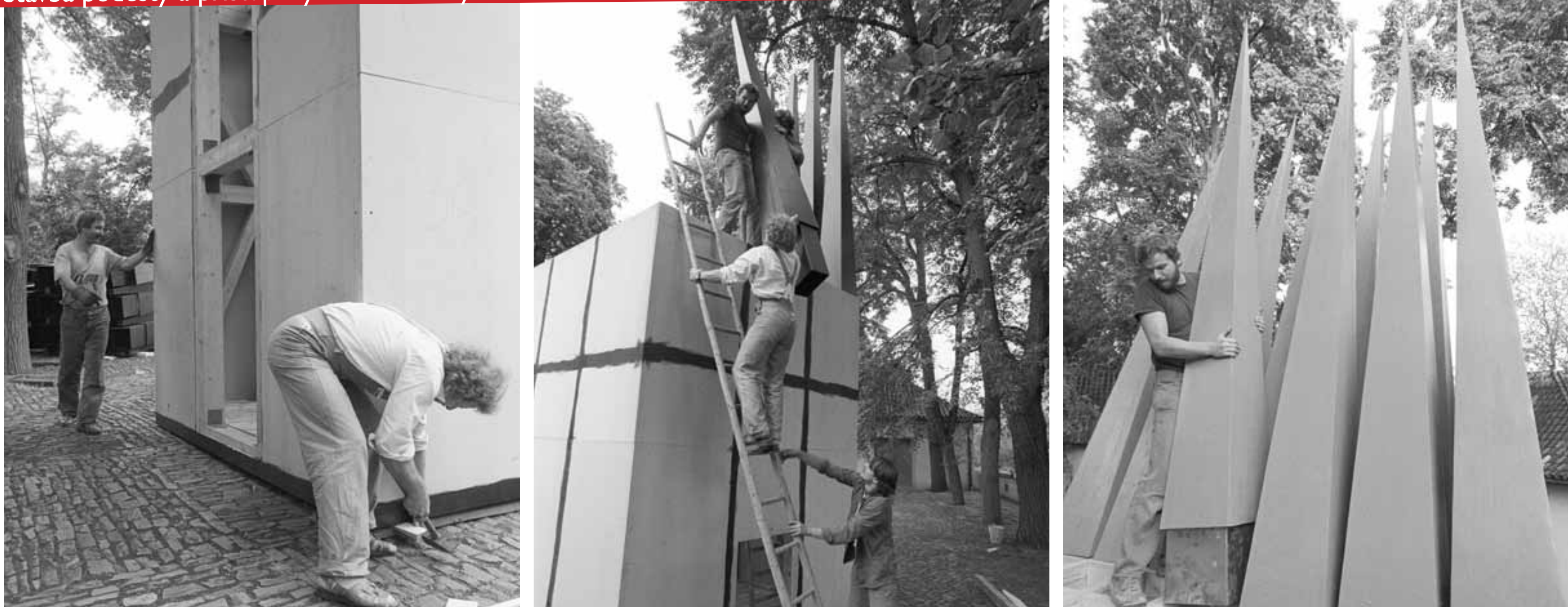
Dřevěné trny se do rámu konstrukce zasazovaly pomocí kovových nástavců, které zajišťovaly naklonění trnů ve správném úhlu, proto bylo nutné dodržet jejich pořadí a umístění.
